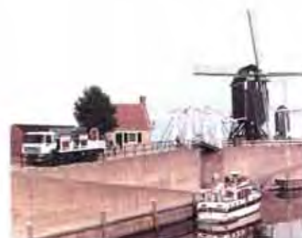
In der Niederlande wird ein Umfüllwerk für Industriegase ausgebaut.
