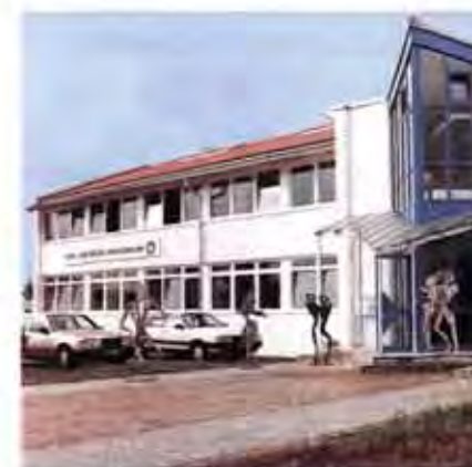
Das im Westen Münchens errichtete Vertriebszentrum und Füllwerk dient als Verteilerzentrale für Industriegase in Bayern.
