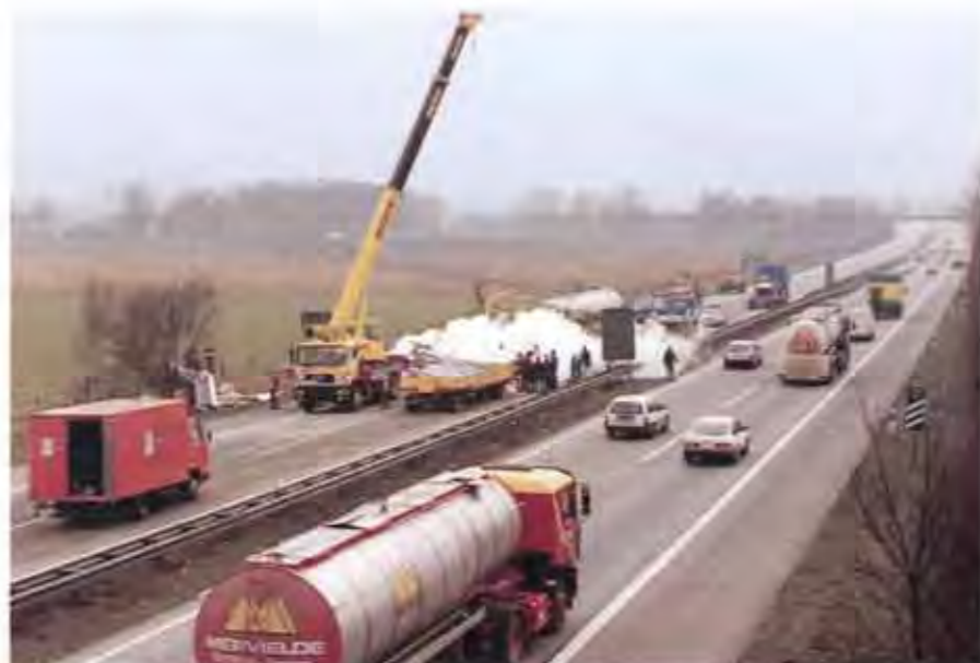
Als Dichtungsmasse nach einem LKW-Unfall die Autobahn verklebte, konnte die Flüssigkeit mit tiefkaltem flüssigem Stickstoff verfestigt und abgetragen werden.
