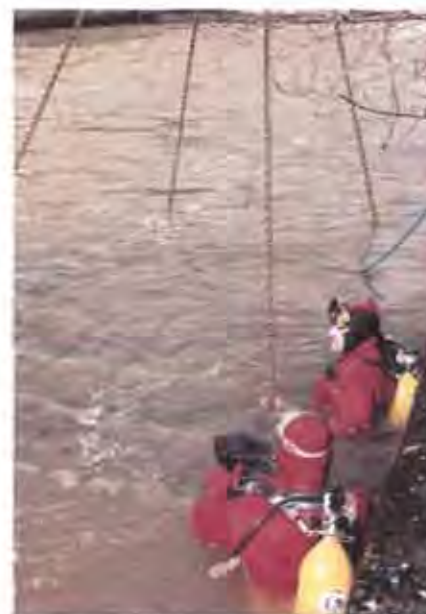
Täucher installieren Belebungsanlagen, über die der Sauerstoff...
