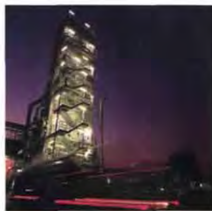
Sauerstoff, Stickstoff und Argon gewinnt Messer Griesheim für den industriellen Bedarf in großen Luftzerlegungsanlagen wie in Frankfurt am Main durch Verflüssigen und Trennen der Luftkomponenten. Unsere Ingenieure planen, projektieren und bauen diese Produktionsanlagen. Die Industriegase gelangen per Fernleitung, Tankwagen oder in Flaschen zu den Kunden.
